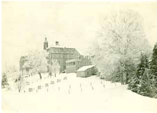
Vieux garage et hangar 1927
