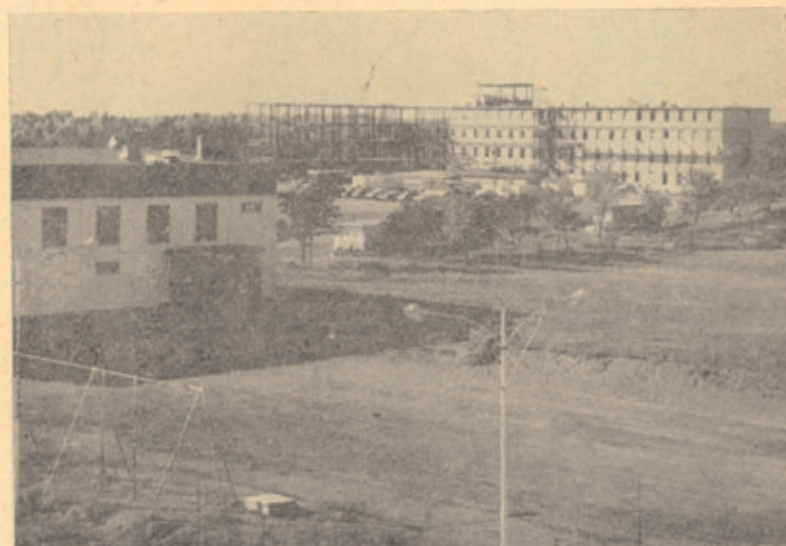
Le Collège Maria Assumpta en construction. La résidence logera les étudiantes du collège. Nous remarquons au premier plan le gymnase et l'auditorium.
